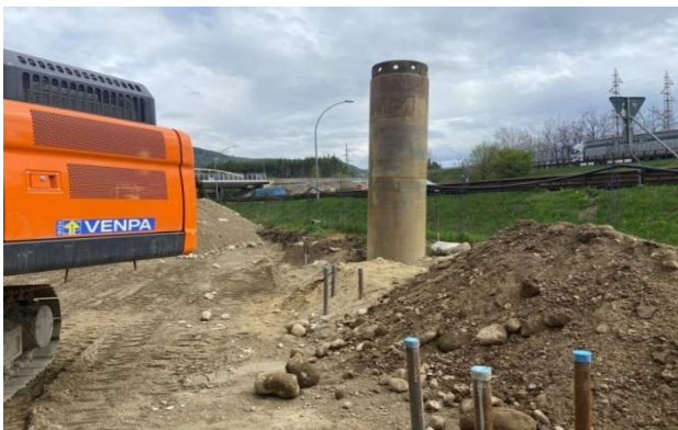
Figura 2: GA01 – Esecuzione paratia pali lato Varna
