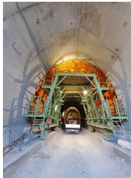
Bild 3: GA01 – Einmündung des Olympia-Tunnels, Seite Natz-Schabs
