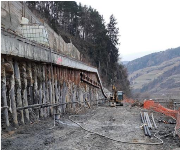
Figura 2 – Paratia per viabilità di accesso all'imbocco della galleria Gardena (NV06) – dicembre 2025
