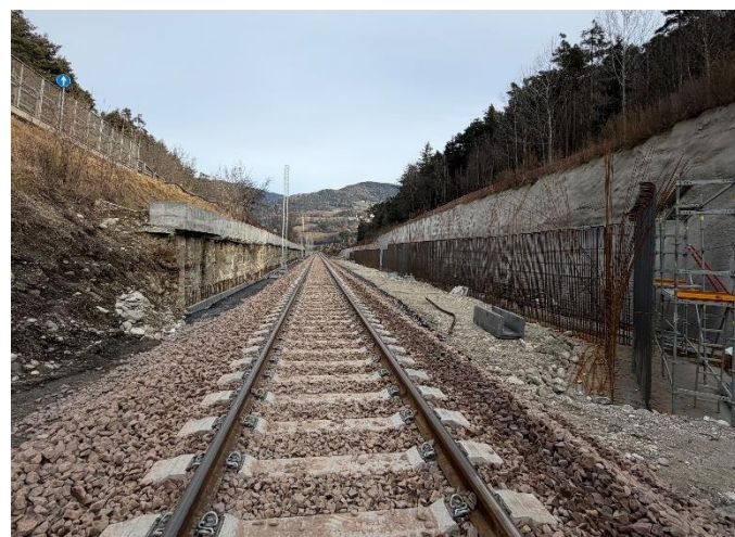
Bild 8: TR41 e RI41 – Fertigstellung der Bauwerke
