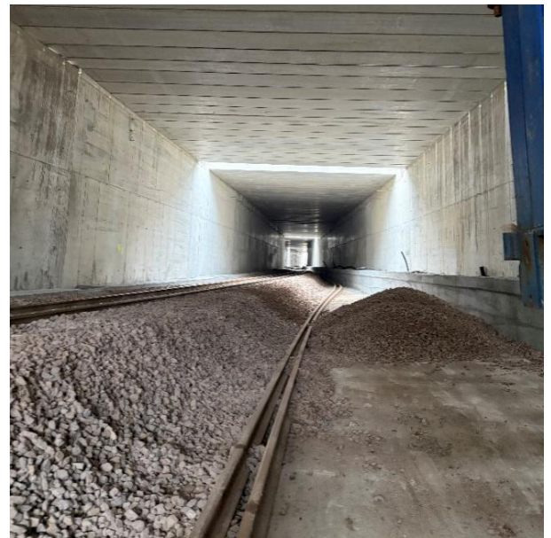
Bild 5: GA06 – Künftiger Anschlusspunkt der Eisenbahn- verbindung
