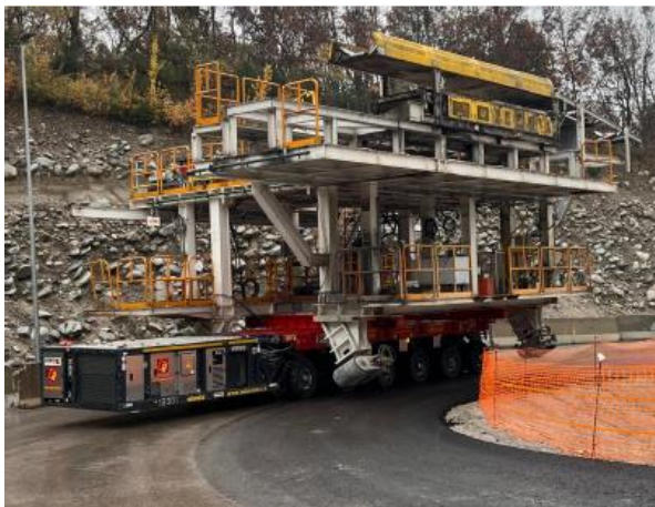
Figura 1 – Smontaggio TBM di Forch (ottobre 2025)
