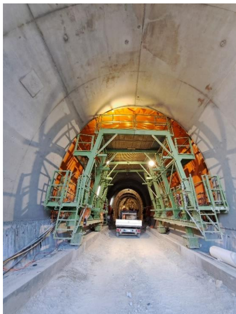
Figura 3: GA01 - Imbocco Galleria Olimpia lato Naz-Sciaves
