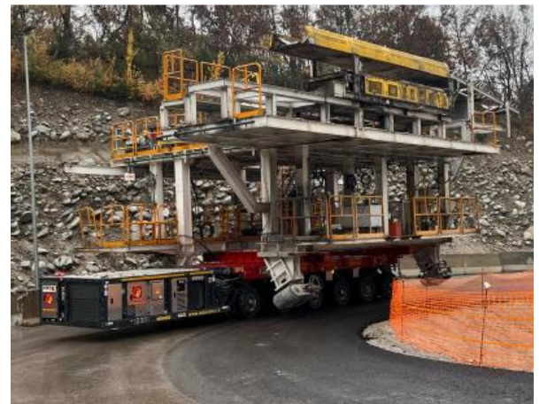
Bild 1 – Demontage der TBM von Forch (Oktober 2025)
