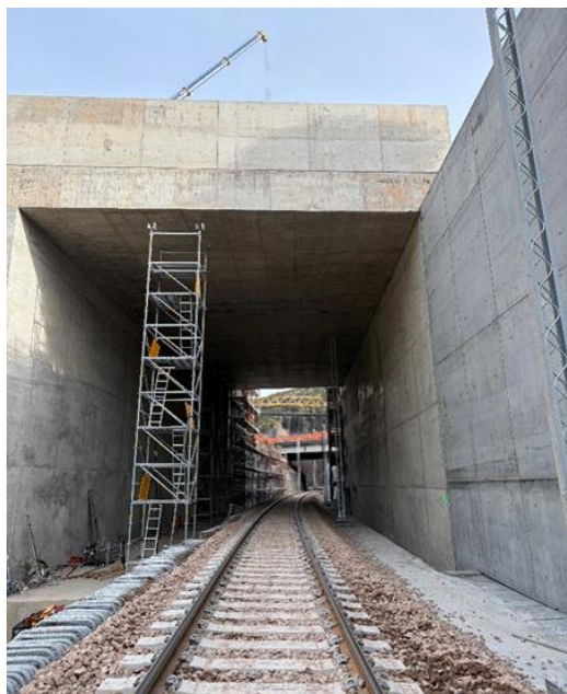
Figura 7: GA07 - Completamento galleria artificiale
