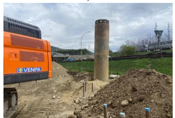
Bild 2: GA01 – Errichtung der Pfahlwand, Seite Vahrn
