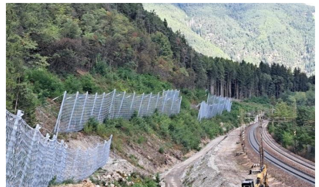
Bild 2: RI21 – Erweiterung des Bahndamms der Bestandsstrecke der Brennerbahn
