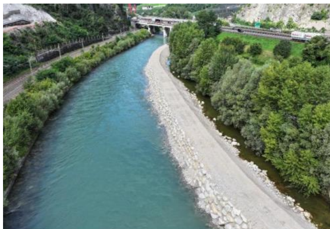
Figura 5 – Argine provvisorio (luglio 2025)
