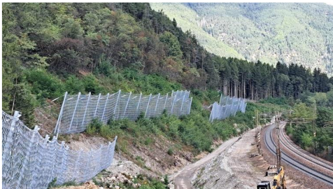
Figura 1: RI21 – Allargamento rilevato linea storica
