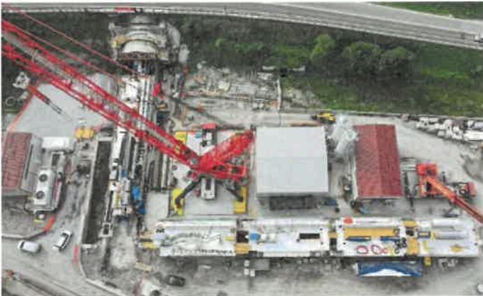
Figura 2- Avvio scavo finestra Funes con TBM
