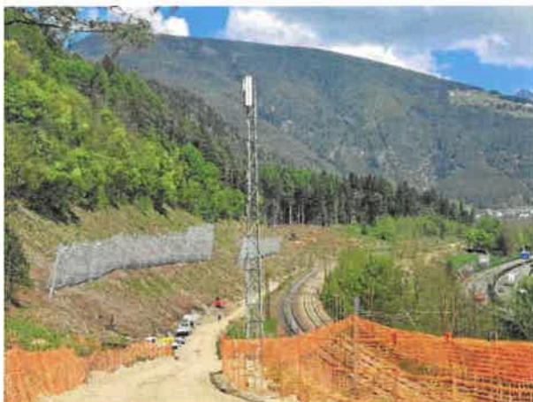
Figura 1: RI21B - Installazione reti paramassi
