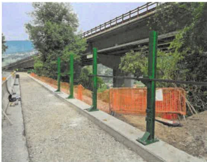
Figura 4 – Installazione barriere antirumore lungo la SS 242
