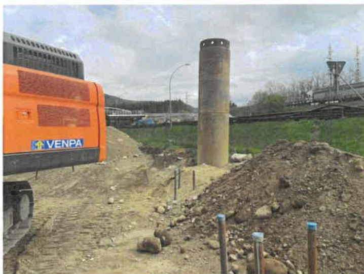
Figura 3: GA01 - Esecuzione paratia pali lato Varna
