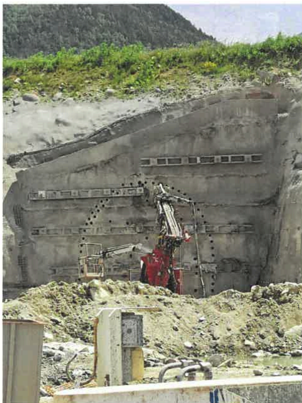
Figura 4: GA03 - Imbocco Galleria Olimpia lato Naz-Sciaves
