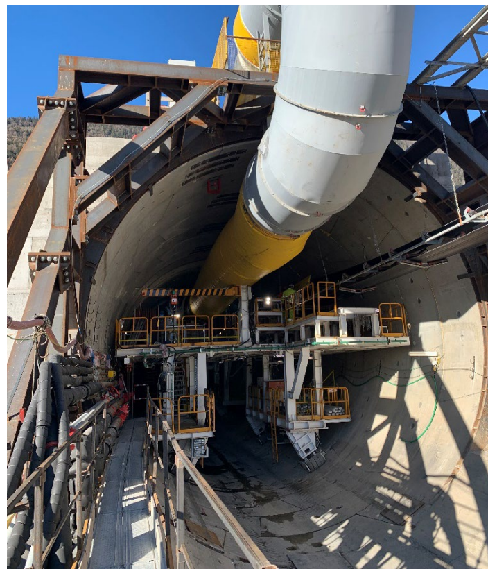
Abbildung 2 – Ausbruch des Fensterstollens Forch
