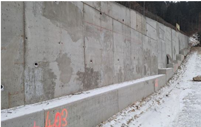
Figura 3 – Muri di sostegno NV06
