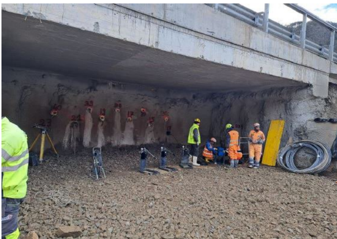
Figura 4 – Iniezioni teleguidate imbocco
