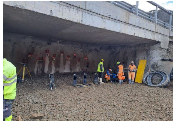
Abbildung 4 – Ferngesteuerte Injektionen am Tunnelportal
