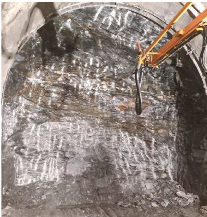
Figura 5 – Fronte di scavo della finestra di Chiusa
