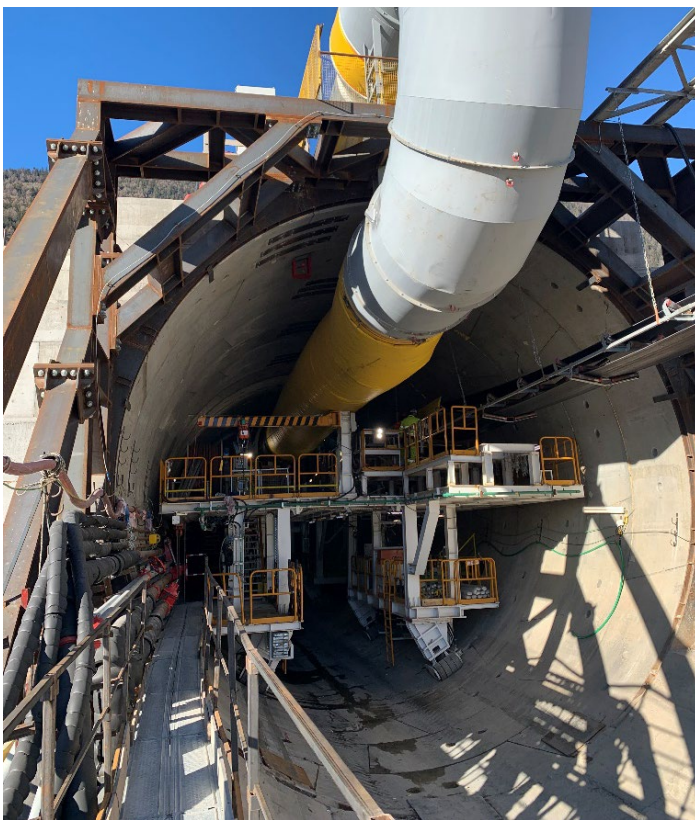
Figura 2 – Scavo della finestra di Forch
